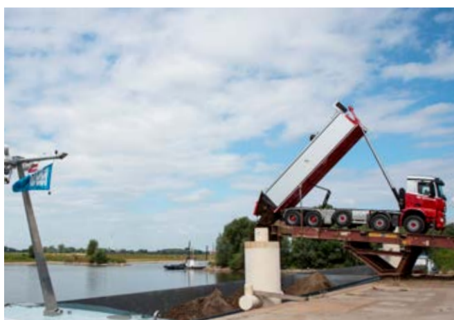
De klei wordt via vrachtwagens over een zogenoemde Baileybrug in het schip geladen.
